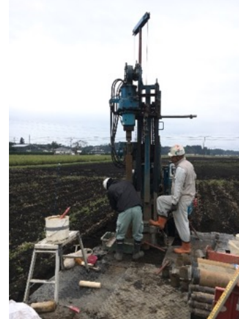
畑地下層の窒素ボーリング調査
